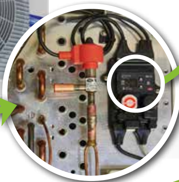
Elektrisches Expansionsventil und Steuergerät.
