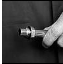
Übergangskupplung auf Sauberkeit und korrekten Sitz der Dichtelemente überprüfen. \triangleright B \triangleleft Oyster auf das Rohr schieben. Dabei kein Öl- oder Gleitmittel verwenden.
