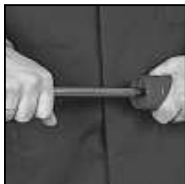
Kupferrohr außen und innen sorgfältig entgraten. Weiches Kupferrohr ist zu kalibrieren.
