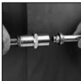
Die beiden Übergangskupplungen mit dem Bänninger Oyster-Kompensator handfest verschrauben.
