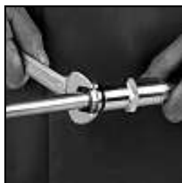
Übergangskupplung und Kompensator mit Gabelschlüssel verschrauben.
