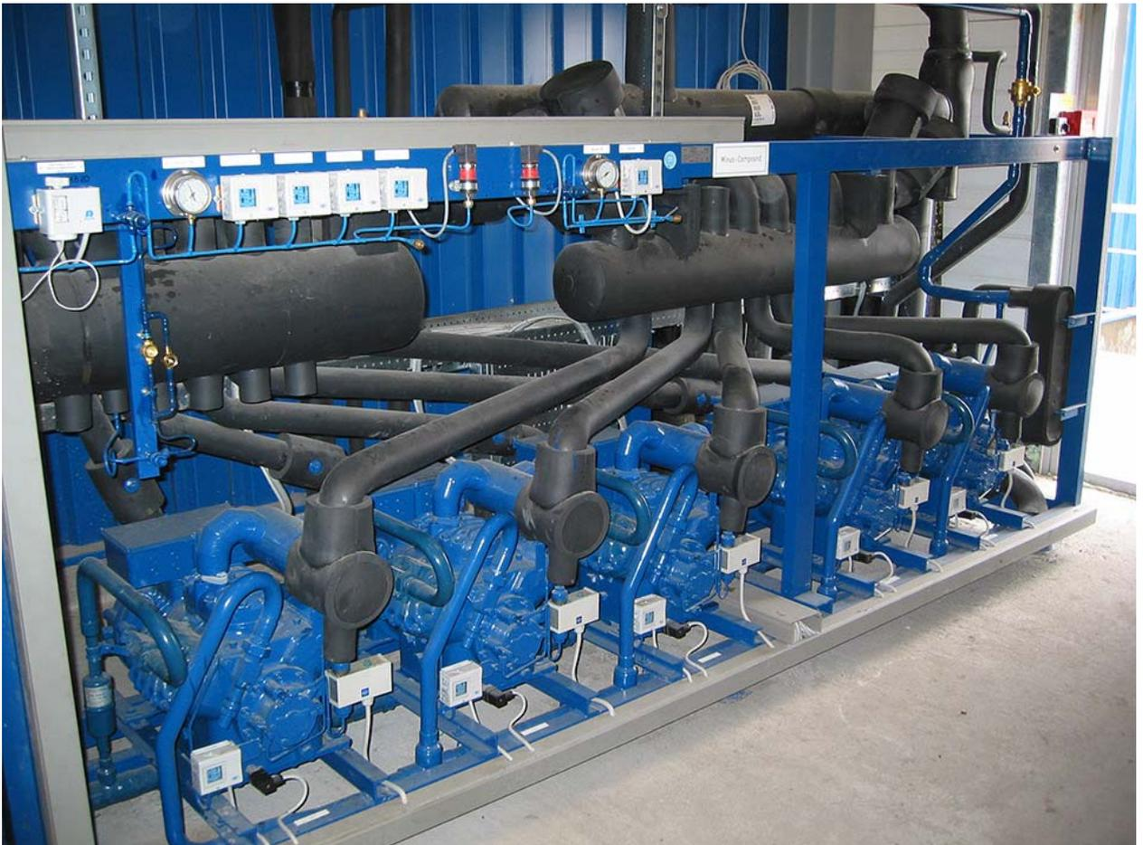
Низкотемпературная централь фирмы Linde с двухступенчатыми компрессорами Битцер S6F-30.2
